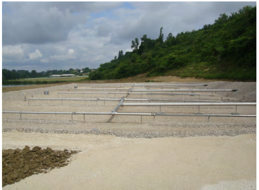
Filtre planté de roseau (1000 eqH) implanté dans un 1 er bassin de lagunage : commune de Villebrumier
