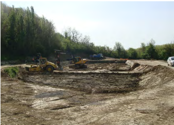
Terrassement en cours dans un bassin de lagunage.
